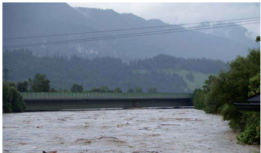
Blick auf die Autobahnbrücke im Jahr 2005
